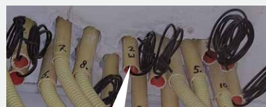
Lege buizen met een zwarte controledraad in het plafond van de meterkast
