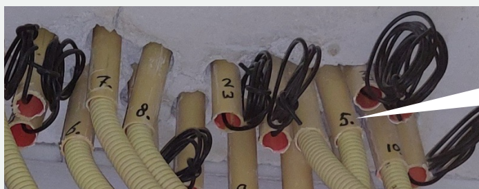
Lege buizen met een zwarte controledraad in het plafond van de meterkast
